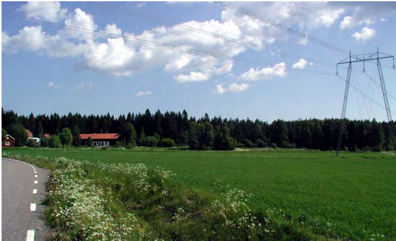
Tillgång till mark för en kraftledning erhålls vanligen genom upplåtelseavtal där markägare ersätts med engångsbelopp. Bilden visar odlingsmark vid Elinge.
