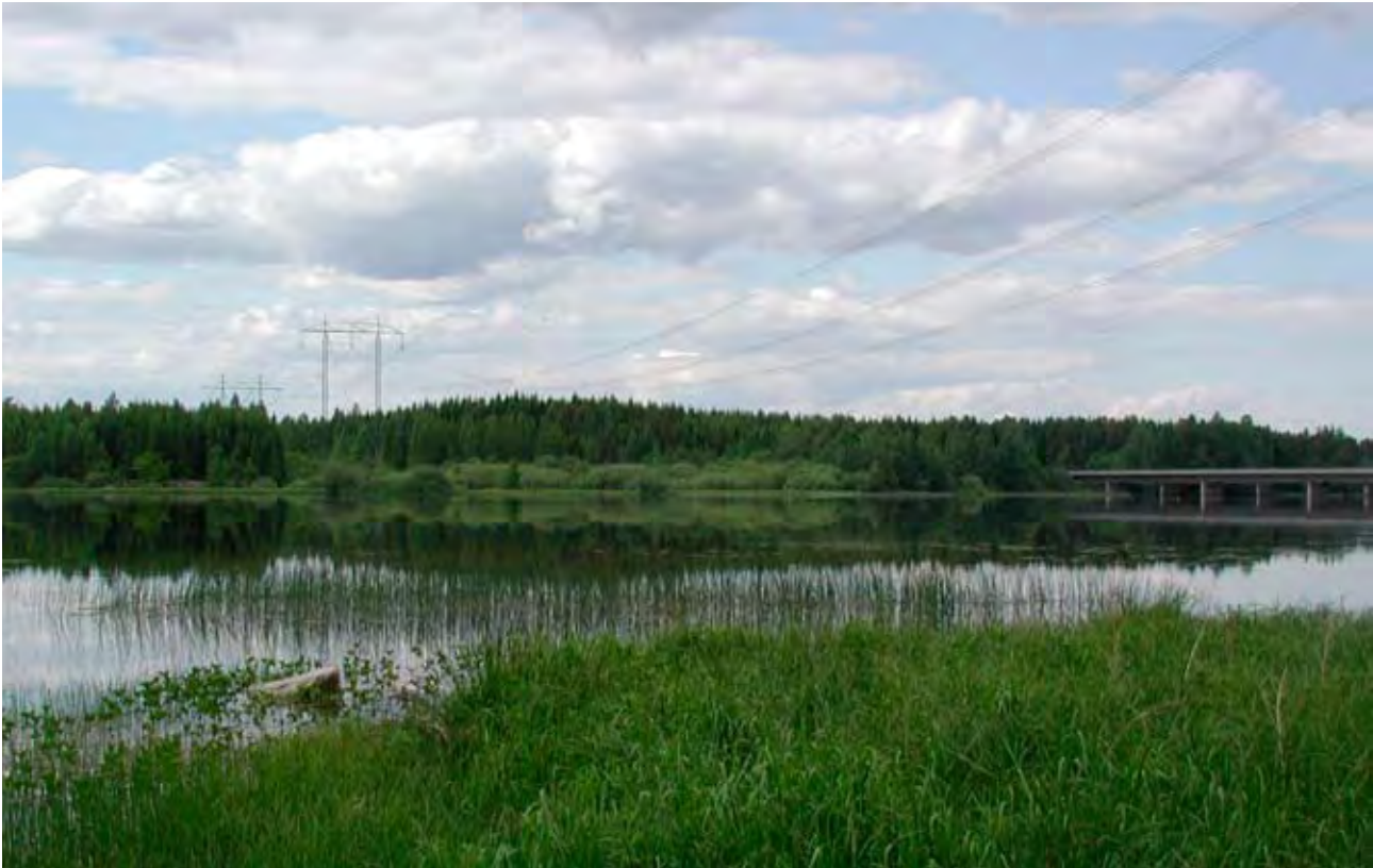
Passage av Dalälven. Den planerade likströmsledningen planeras parallellt, norr om befintlig 400 kV ledningen (till höger om ledningen i bild). E4 syns till höger i bilden. Foto taget mot väster. Se också flygbild på sida 33.
