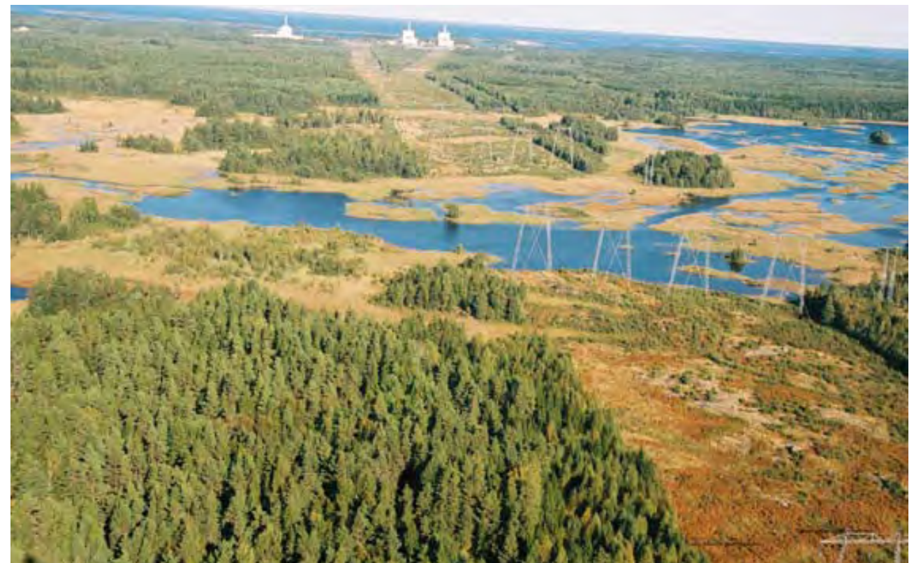
Bruksdammen med Forsmarks kärnkraftverk och befintliga fyra 400 kV ledningar och en 70 kV ledning. Området utgör en del av Natura 2000-området och är bland annat av riksintresse för naturvård och kulturmiljövård mm. Utbyggnadsförslaget av ny ledning går norr om befintlig ledningsgata. (till vänster om ledningarna i bild)
