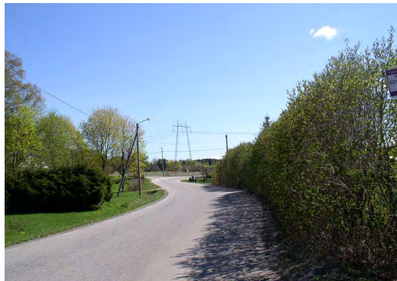
Det magnetfält som bildas vid ledningar med likström är av samma typ som det jordmagnetiska fältet och bedöms därför inte påverka människors och djurs hälsa. Fotot taget från bebyggelse i Elinge ut mot befintlig 400 kV ledning.
