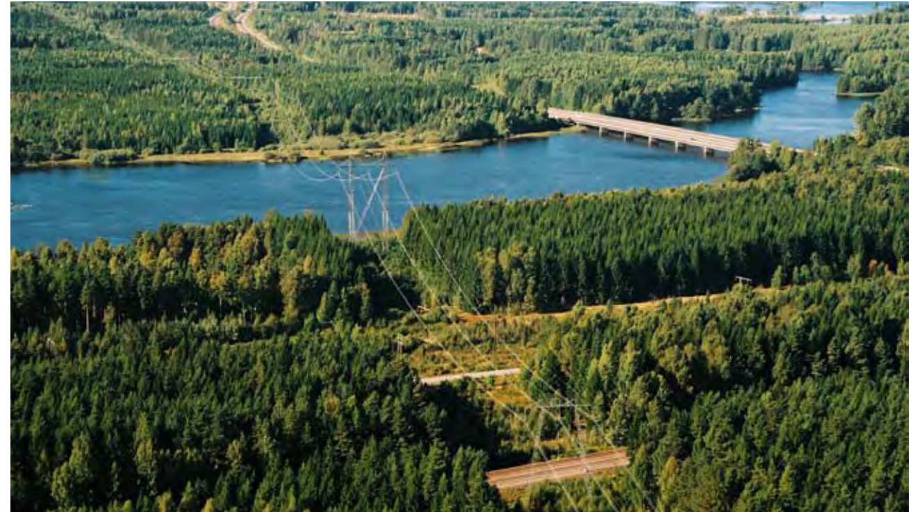
Passage av Dalälven norr om Untra Kraftstation. Den planerade likströmsledningen planeras parallellt, norr om befintlig 400 kV ledningen (höger om ledningen i bild). E4 syns till höger i bilden. Foto taget mot väster.
